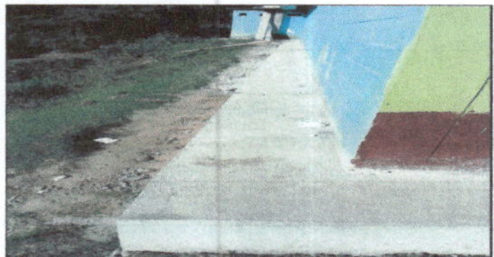
Foto 12: Reparación de plancha de concreto en banqueta de aulas de 3ro, 4to y 6to.
