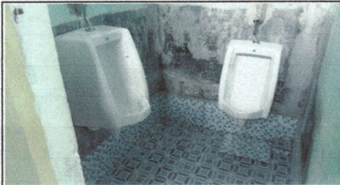
Foto 9: sustitución de mingitorios en baños para niños.
