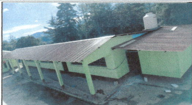
Foto1: sustitución de lámina por lámina troquelada color alum Calibre 26 en aulas de 3ro, 4to, 6to y baños.
