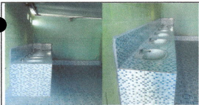
Foto 11: Sustitución de azulejo en baños escolares.
