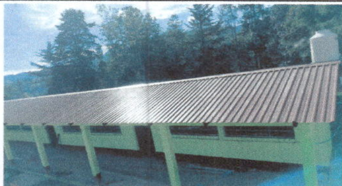
Foto 2: Sustitución de Capote para lámina troquelada en aulas de 3ro, 4to y 6to.
