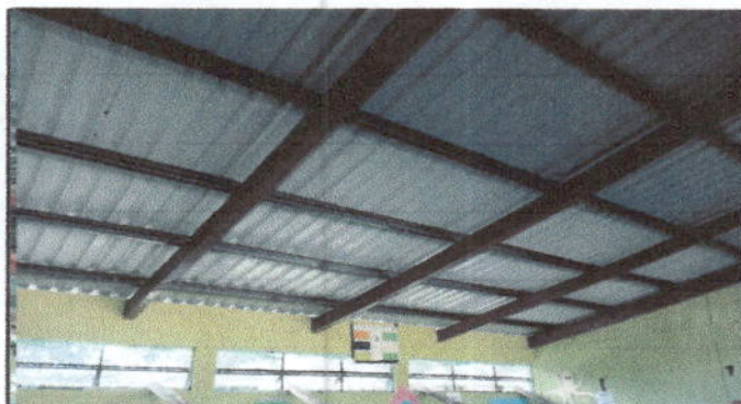
Foto 4: Sustitución de estructura de soporte de madera por metal en aulas de 3ro, 4to y 6to.
