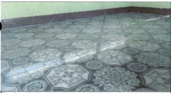
Foto 5: sustitución de piso de cemento líquido por cerámico en aulas de 3ro, 4to y 6to, mas corredor.
